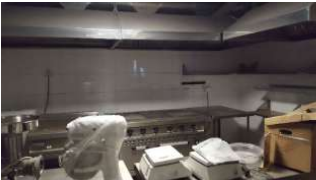
Фото 21. Состояние помещений 1 этажа
