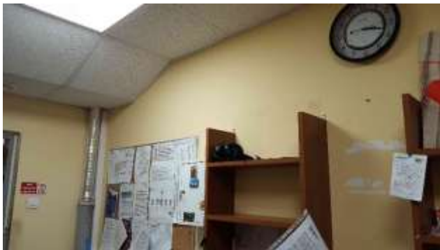
Фото 7. Состояние помещений цокольного этажа
