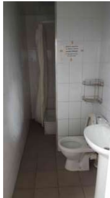
Фото 24. Состояние помещений 1 этажа
