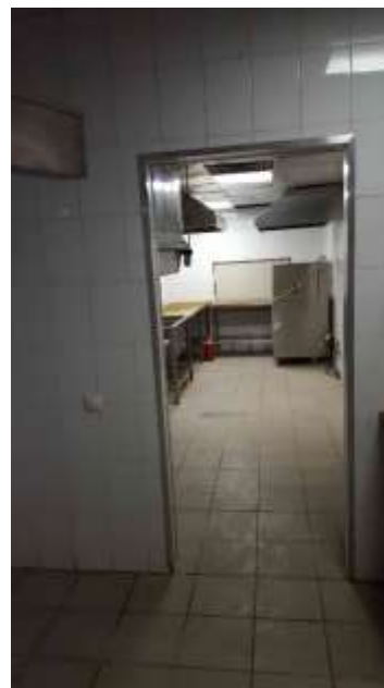
Фото 26. Состояние помещений 1 этажа
