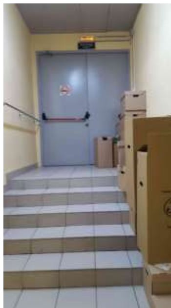
Фото 14. Состояние помещений 1 этажа
