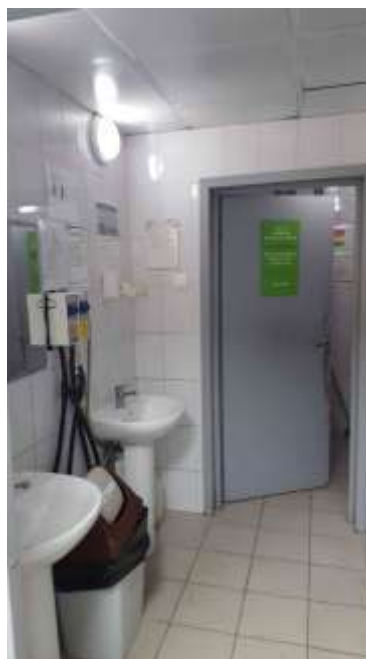
Фото 10. Состояние помещений цокольного этажа
