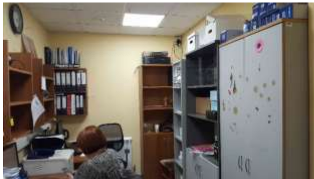
Фото 8. Состояние помещений цокольного этажа
