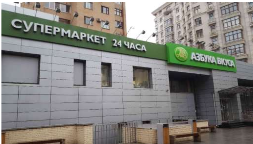
Фото 1. Внешний вид здания
