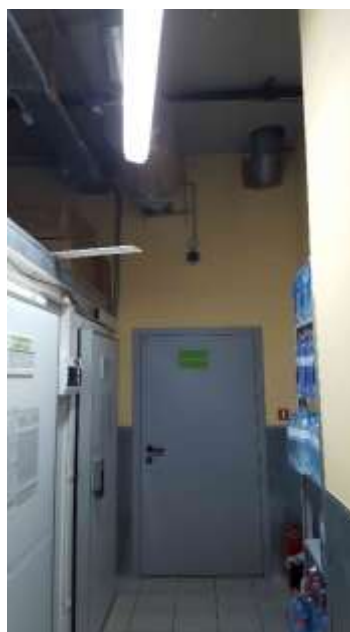
Фото 16. Состояние помещений 1 этажа
