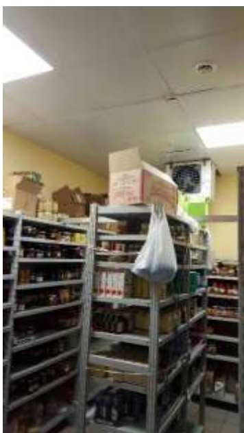
Фото 15. Состояние помещений 1 этажа
