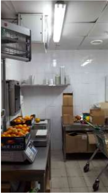
Фото 17. Состояние помещений 1 этажа
