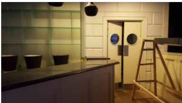
Фото 27. Состояние помещений 1 этажа
