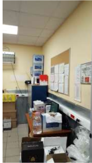
Фото 18. Состояние помещений 1 этажа
